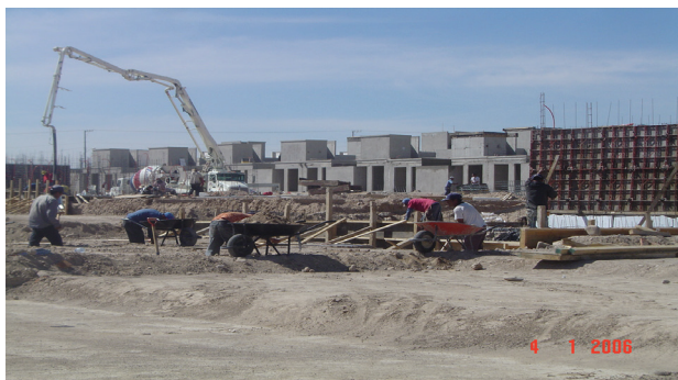
Figura 3. Vivienda de concreto sostenible y sismorresistente
