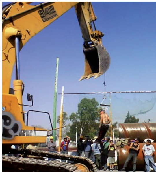
Figura 2. Suspensión realizada en Ciudad Azteca, Ecatepec, estado de México, en una obra de construcción. Fotografía tomada por la autora en 2010.
