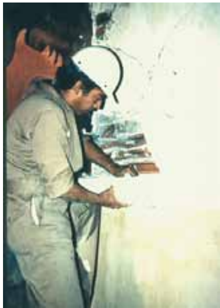
Desprendimiento de un mural del pintor Luis Nishizawa afectado por el sismo de 1985, México, D. F.
