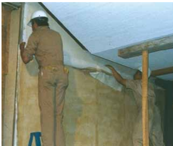
Desprendimiento de un mural del pintor Luis Nishizawa.
