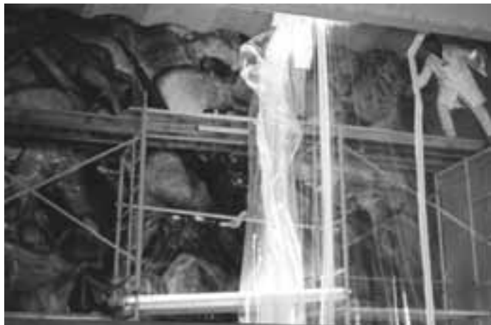
Instalación de la cámara de deshidratación.
