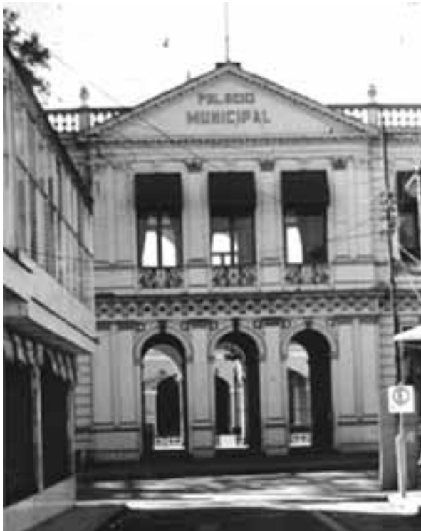
Fachada e ingreso principal al Palacio Municipal (antes Centro Educativo Obrero).
