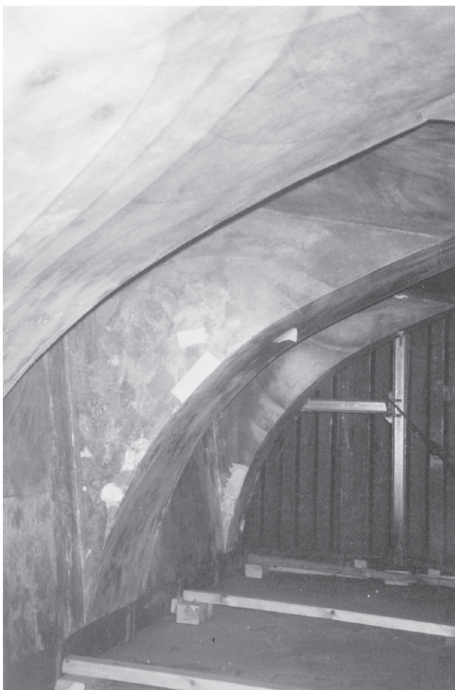
Detalle interior de uno de los contenedores, en el que se aprecia una sección del mural, sin la tela de protección que se había colocado al desprenderlo.
