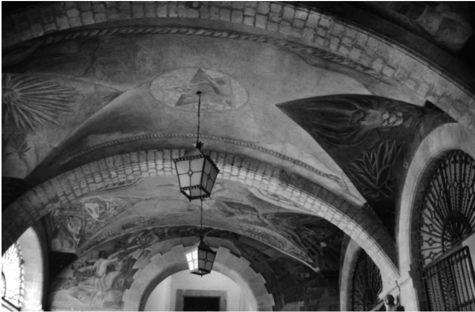
Vista de las dos primeras bóvedas. Foto: Adrián Soto
