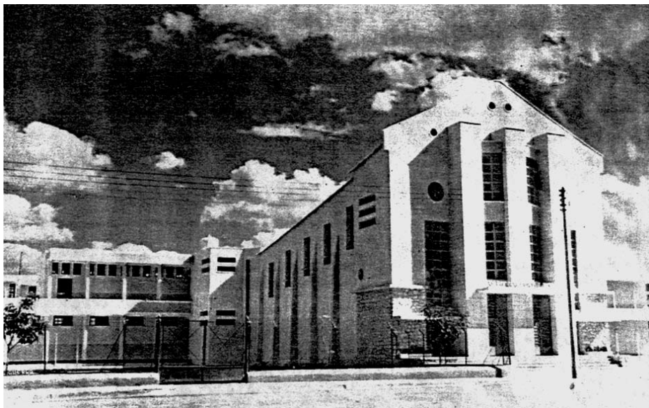
Arq. Manuel Amábilis. Fachada y puerta principal del Centro Escolar Felipe Carrillo Puerto. Mérida, Yucatán. 1943-1945. Destruído.*
