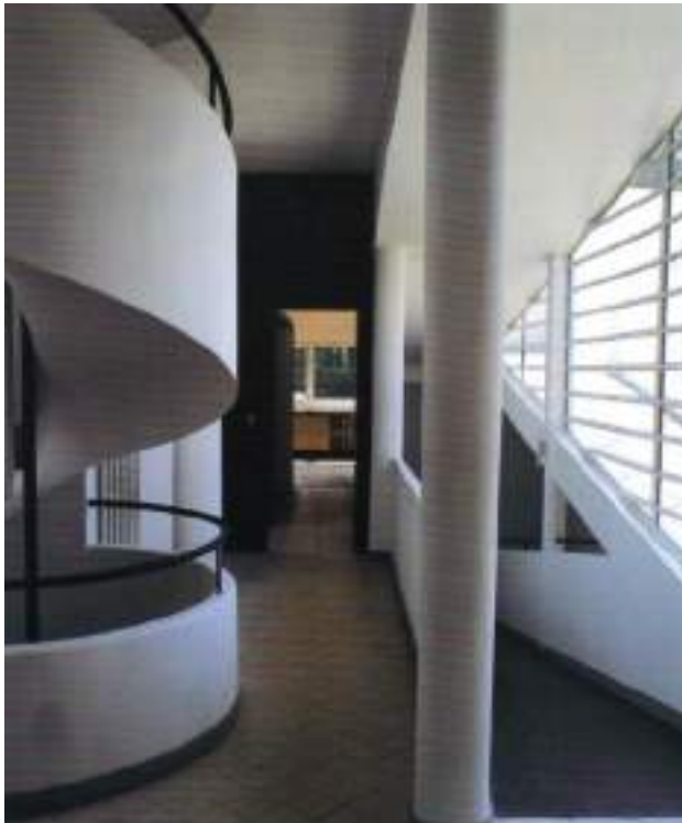
Villa Savoye. Vista que incluye la participación de las dos modalidades de ascenso (rampa y escalera), ambas como distintas propuestas, plásticas, espaciales y de recorrido. Fuente: Delia King, Alicia Paz González y Andrea Martín, Arquitecturas de recorrido , México: UAM Xochimilco, 2009, p. 26.
