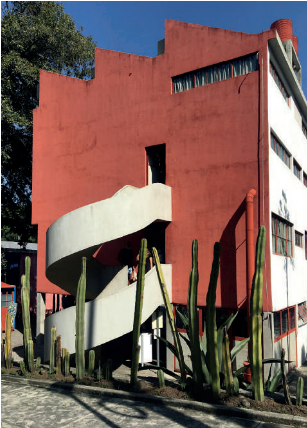
Casa-estudio Frida Kahlo y Diego Rivera. Presencia de los distintos postulados de la arquitectura moderna. Recursos formales identificables en su referente arquitectónico fundamental de su primer período, el arquitecto Le Corbusier. Fotografías de Arq. Víctor Morel y la autora, 2022.
