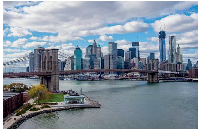
La metrópoli en el marco de la arquitectura contemporánea. Puente de Brooklyn, EU. Fuente: < https://miviaje.com/los-mejores-puentes-de-estados-unidos >
