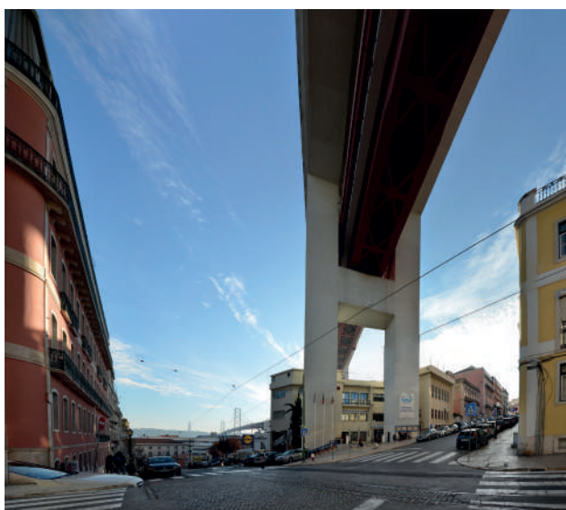
Pilar 15 en el acceso al edificio-sede de la Freguesía de Alcântara. Fotografía del autor, 2018.
