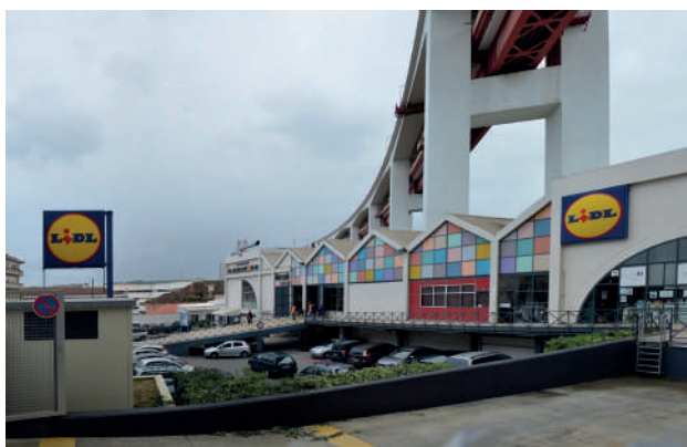
Pilar 14 en el Mercado de Alcântara. Fotografía del autor, 2018.
