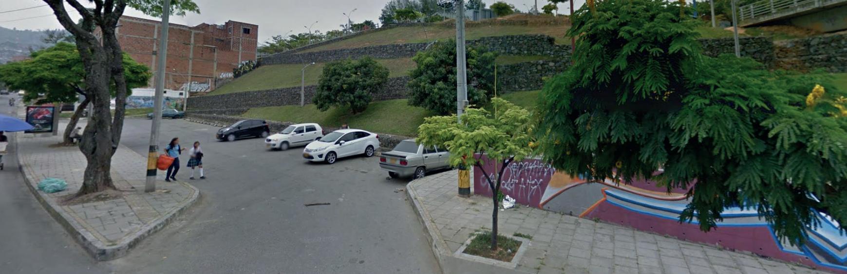
Figura 14. El sector A desde la Carrera 96. Obsérvese el edificio que interrumpe su continuidad en un terreno muy abrupto. Se asoma mínimamente el edificio de la biblioteca. Fuente: Google Street View.
