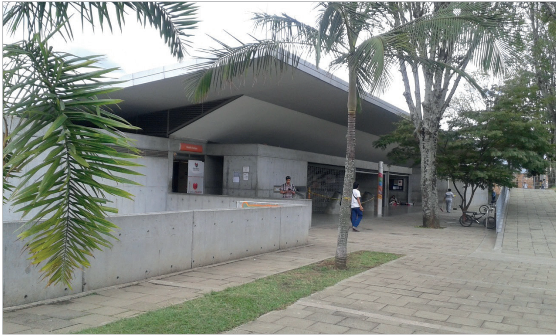
Figura 17. Sector D, en el ingreso principal al edificio de la biblioteca. Fotografía del autor.
