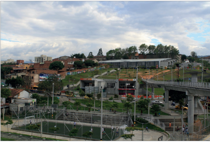
Figura 15. Vista general con el Sector B y la fachada norte al medio Fuente: comunadoce.wordpress.com.
