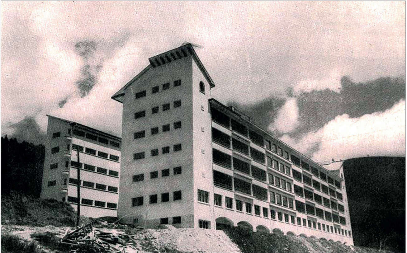
Estado actual del sanatorio antituberculoso de Busot (Alicante). Primer sanatorio construido en España en 1897. Fuente: wikimedia commons.
