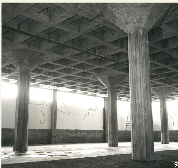
Casetonado y columna octogonal del edificio Banbury en construcción. Fuente: Archivo FATE
