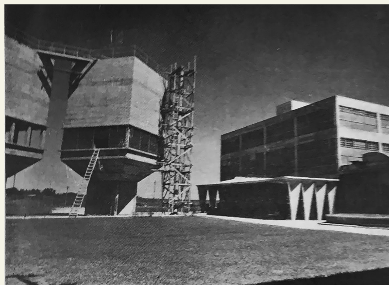
Torres de enfriamiento y plegado del sector de recepción de material de la fábrica. Fuente: Obrador 1, 13
