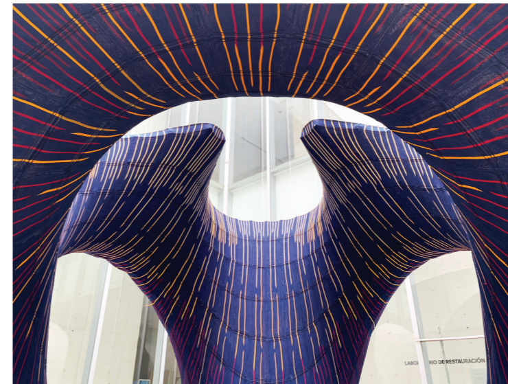
Construcción de KnitCandela. La manipulación de los materiales en la etapa digital
