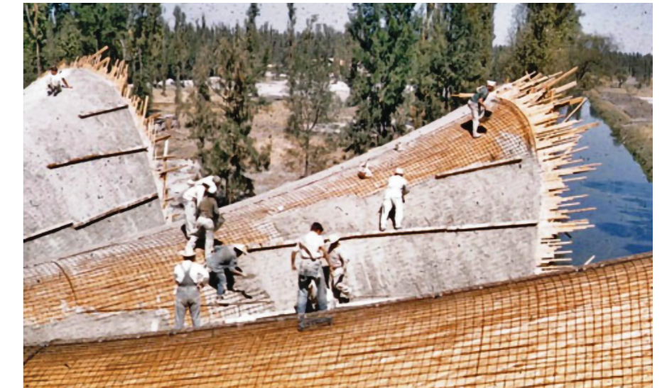
Construcción del restaurante Los Manantiales de Félix Candela. La manipulación de los materiales en la etapa predigital. Fuente: Karina Duque, “Clásicos de arquitectura. Restaurante Los Manantiales / Félix Candela,” ArchDaily
