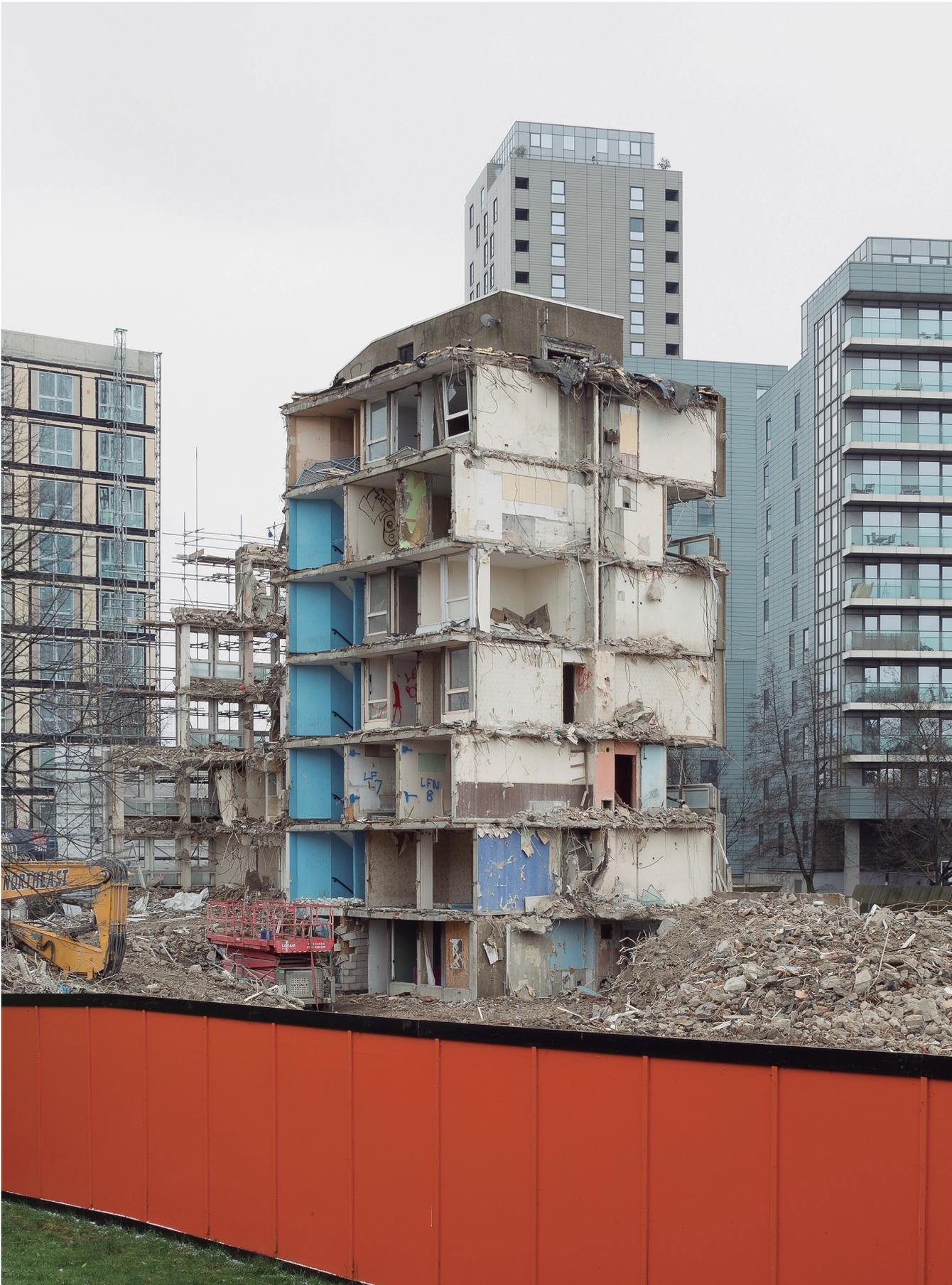
La parte central de Robin Hood Gardens fue demolida primero y se dejó para el final sus núcleos verticales de hormigón más masivos en ambos extremos. Despojados de la icónica fachada, este corte de sección revela su interior doméstico. Los edificios circundantes insinúan el aspecto y la densidad del nuevo desarrollo. Fotografía: ©Francisco Ibáñez Hantke, *Estructuras deconstruidas 3*, Londres, 2017, de la serie *No-Estructuras*
