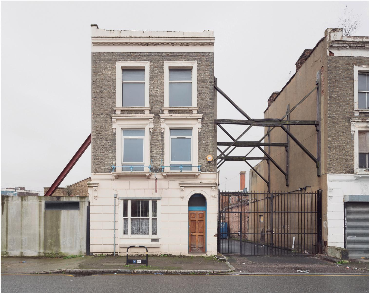
Habiendo perdido el soporte de las estructuras adyacentes, este edificio, ubicado junto a la estación de Finsbury Park, requirió apoyo externo temporal para mantenerse en pie. Ahora se ha demolido para dar paso, junto con otros sitios, a City North, un proyecto de regeneración de uso mixto de 355 viviendas (47 asequibles). Fotografía: ©Francisco Ibáñez Hantke, *Estructuras insostenibles 1*, Londres, 2015. De la serie *No-Estructuras*
