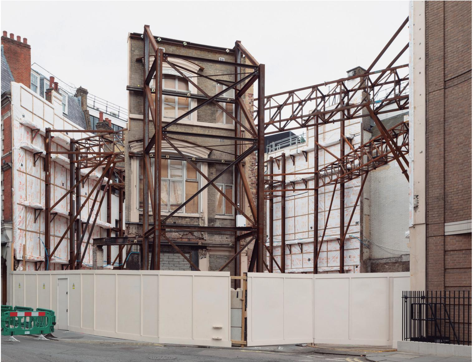
Las estructuras metálicas que sostienen la fachada y los edificios adyacentes dominan esos elementos y parecen implosionar en el vacío central. El proyecto conserva una fachada y reconstruye el sitio (mientras mantiene las alturas existentes) en oficinas y locales comerciales. Fotografía: ©Francisco Ibáñez Hantke, *Estructuras insostenibles 7*, Londres, 2018, de la serie *No-Estructuras*
