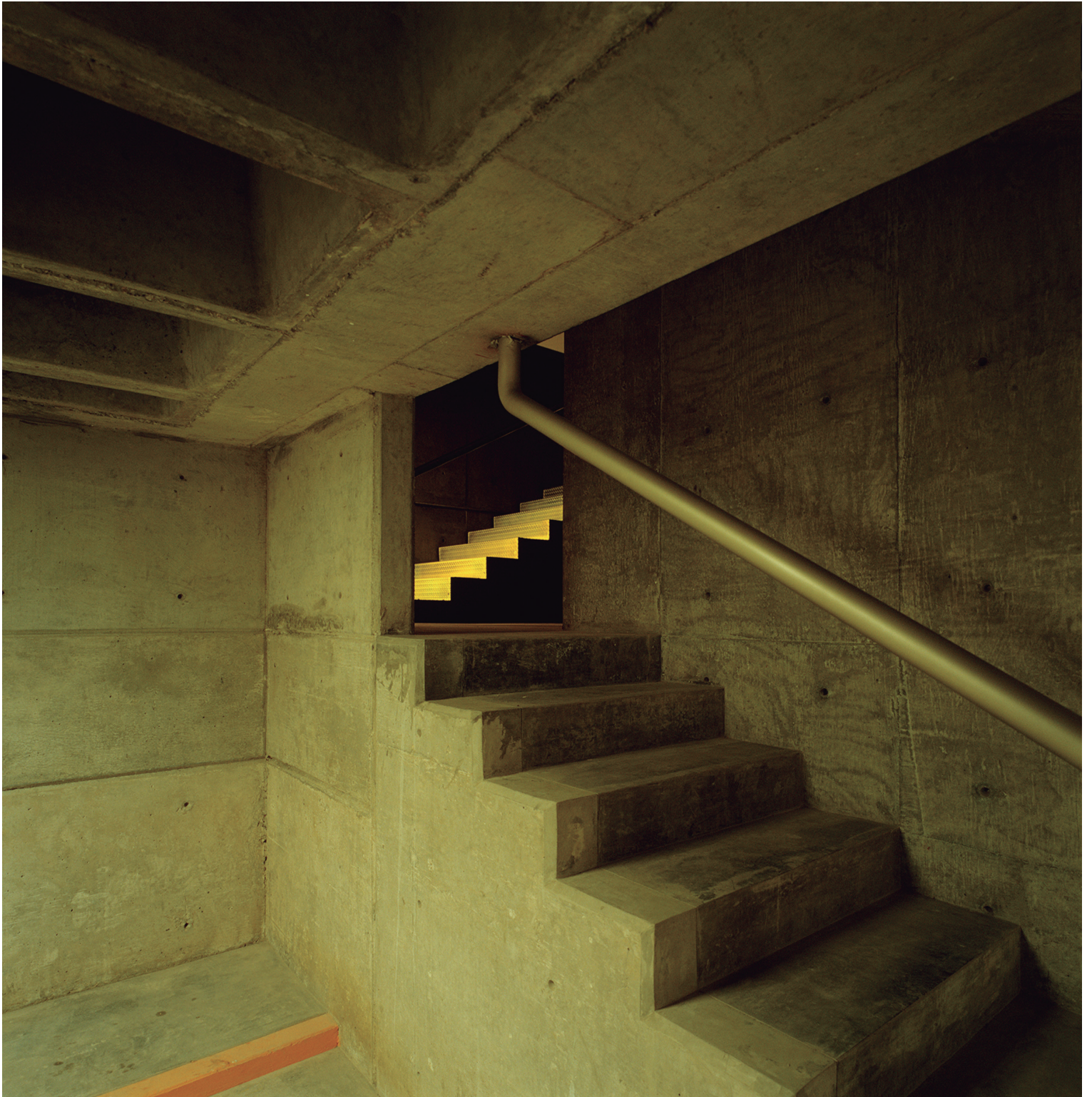
Concreto aparente V. Fotografía: Fernando Cordero, 2002
