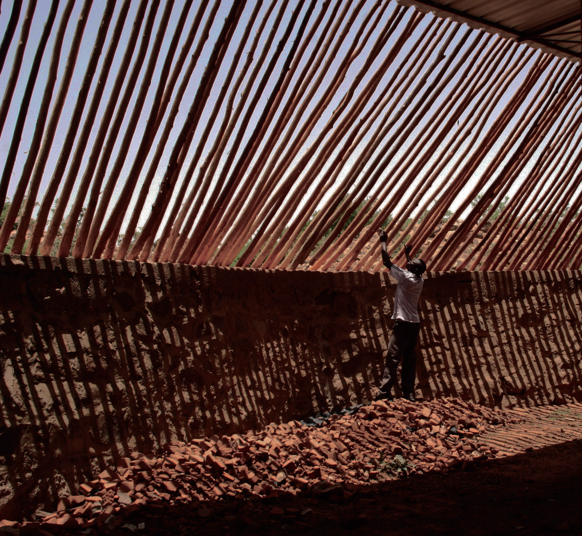
Escuela Secundaria de Naaba Belem Goumma. Gando, Burkina Faso. Kéré Architecture, 2009. Fotografía: cortesía de Kéré Architecture
