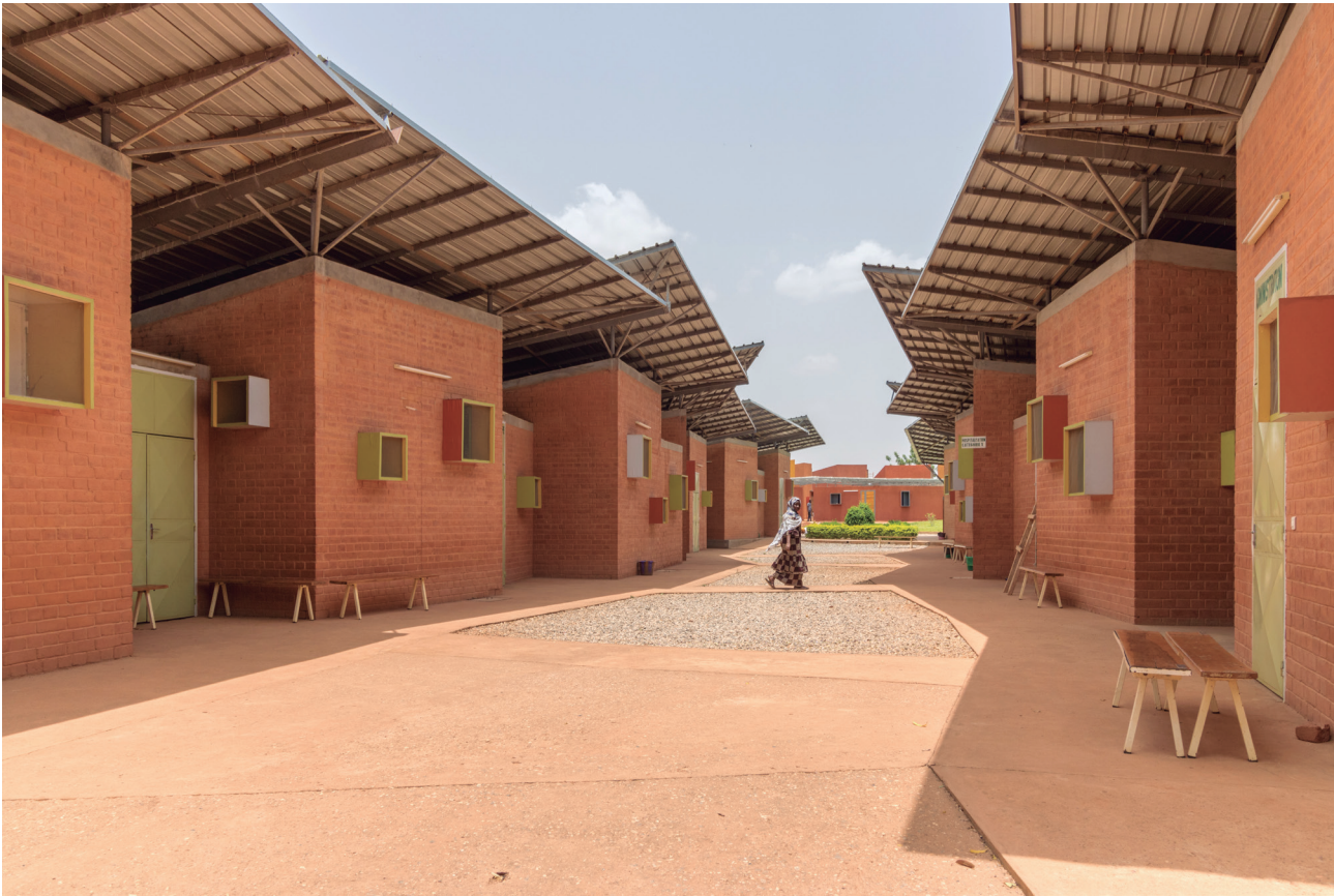
Sistema de climatización pasiva en la Clínica quirúrgica y Centro de salud de Leo, Burkina Faso, Kéré Architecture, 2009. Fotografía: Andrea Maretto, 2018, cortesía de Kéré Architecture
