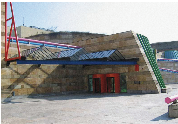
Vista del conjunto desde el punto de llegada de la rampa que parte del nivel de la calle. Fotografía: Musskoprozz
