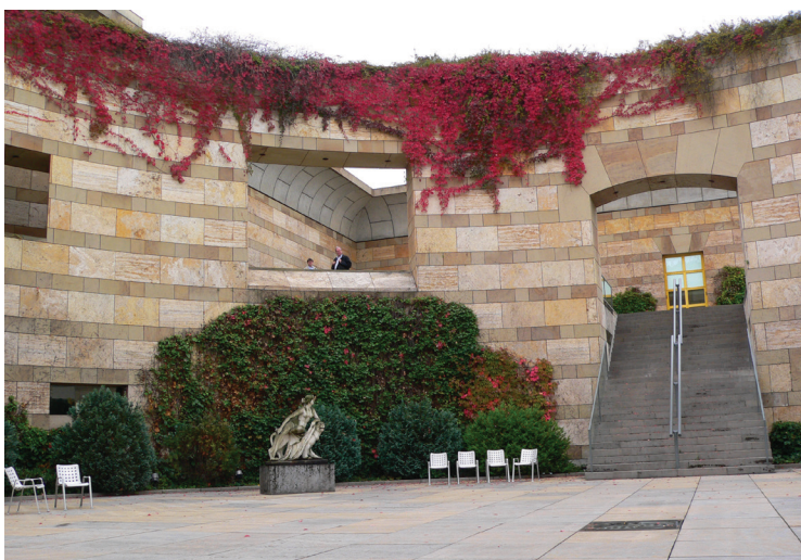
Vista de la escalinata de bajada al patio central desde la terraza superior. Puede verse la ventana francesa que da acceso a la terraza desde las galerías de la exposición permanente. Fotografía: Steve Silverman
