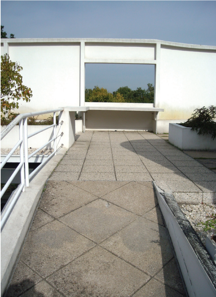
Villa Savoye. Punto de final del itinerario. Fotografía: Óscar del Castillo
