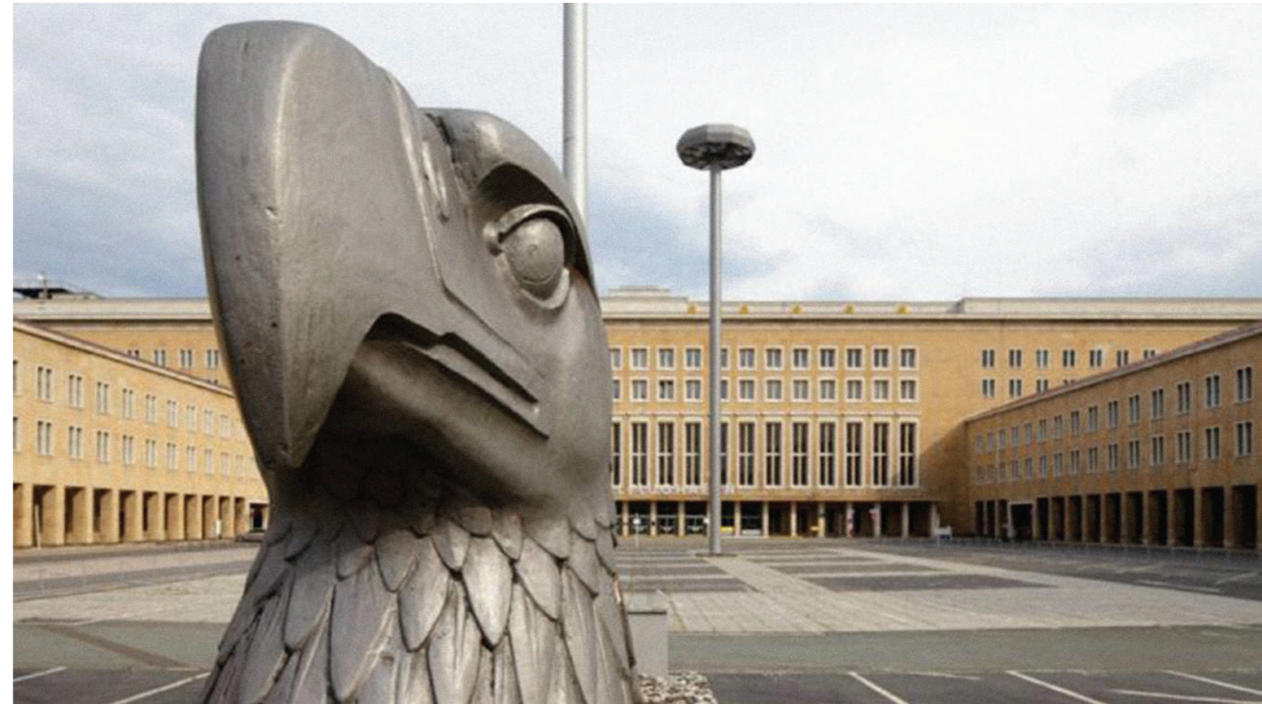
Edificio H2, hacia el exterior del complejo del aeropuerto de Tempelhof. Fuente: Imago
