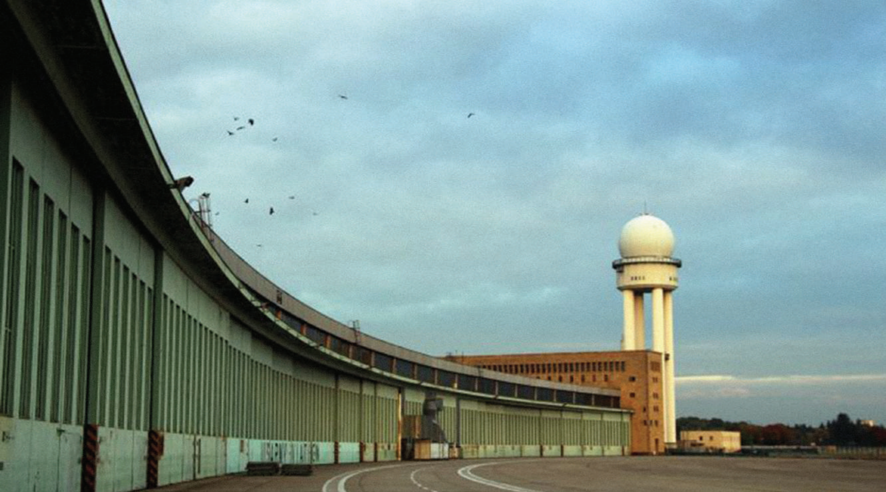
Plataforma del aeropuerto con hangares y torre de radar en el fondo. Fotografía: Sebastian Shöbel
