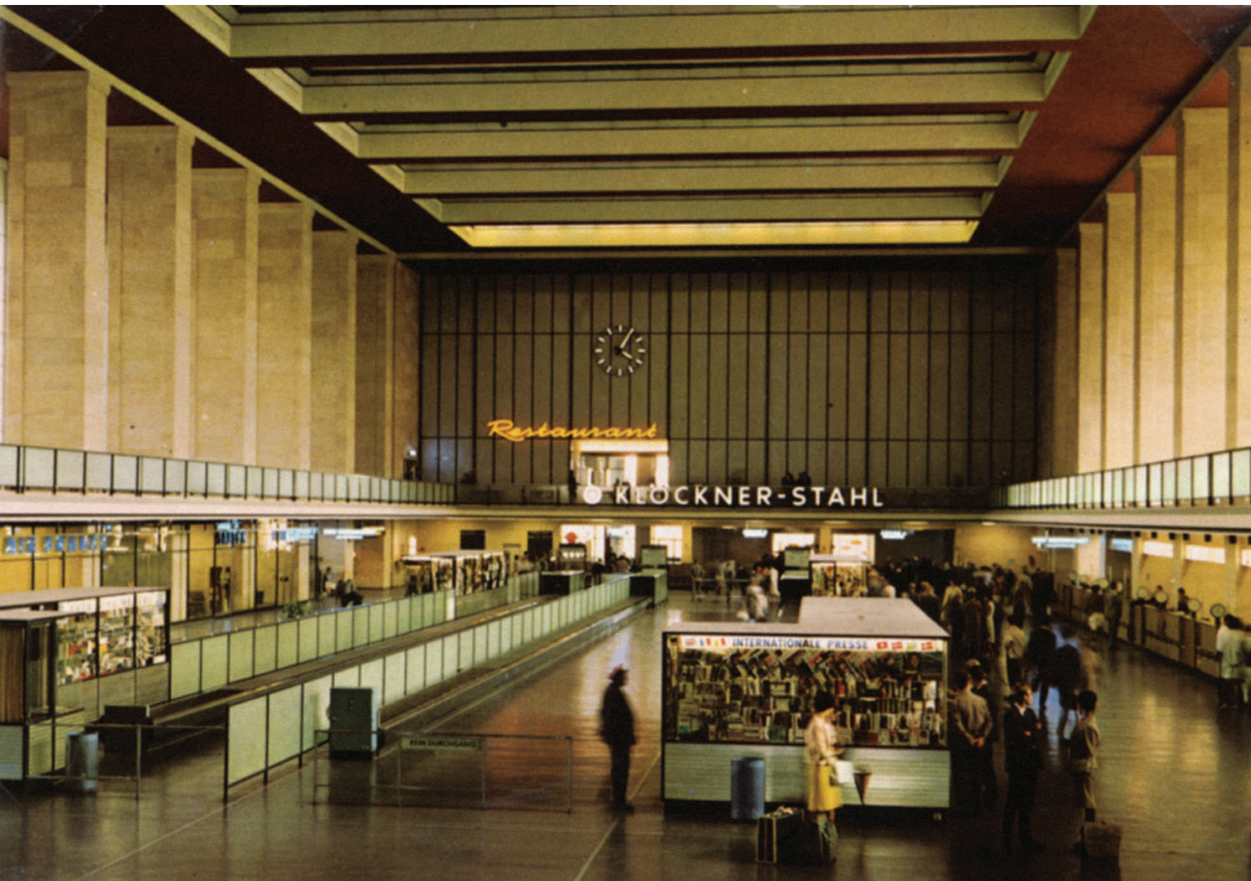
Terminal principal del Tempelhof, 1963. Fuente: © Flughafen Berlin Brandenburg GmbH Archiv
