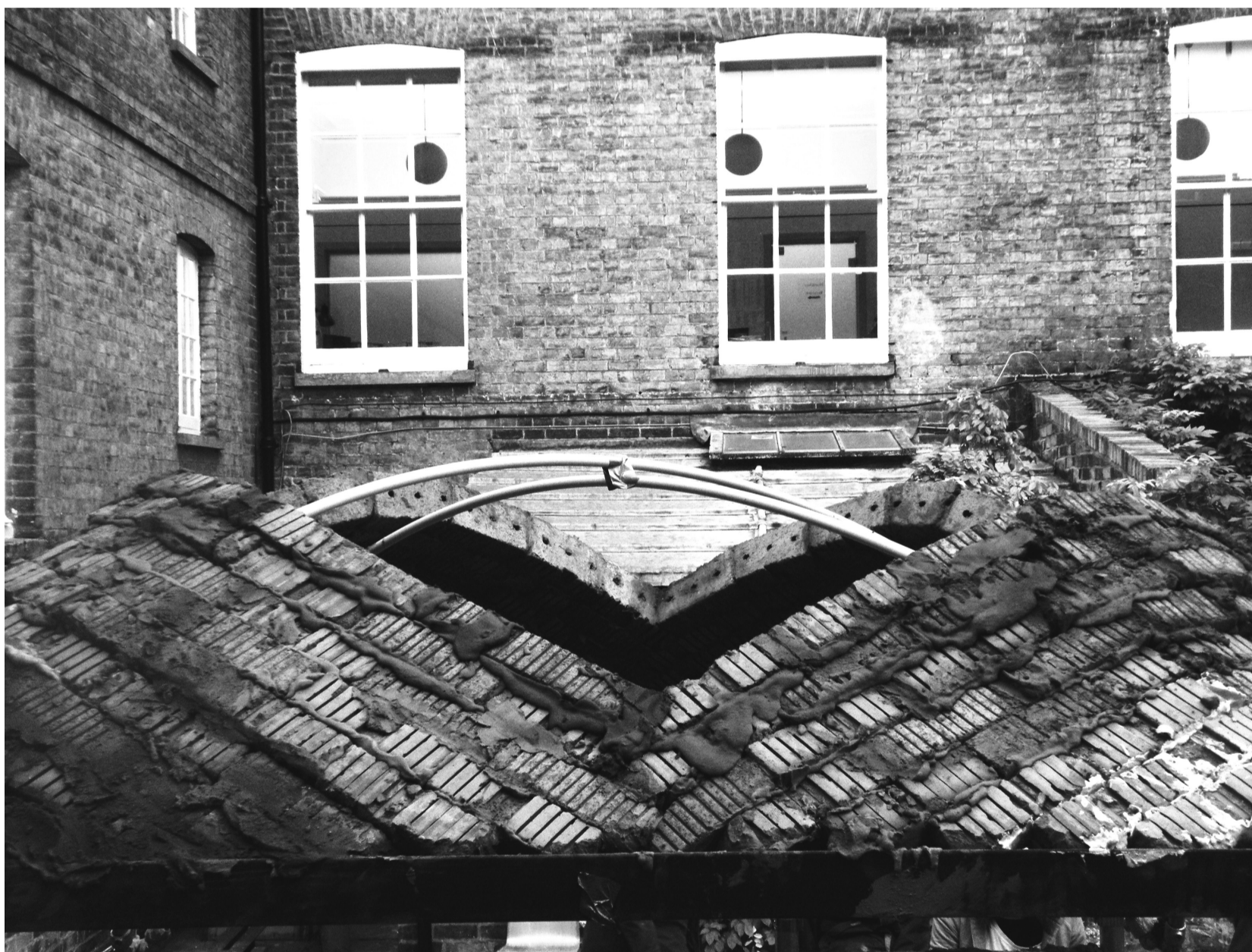
Avance de la cubierta al finalizar el Taller. Fotografía: A. R. Ponce
