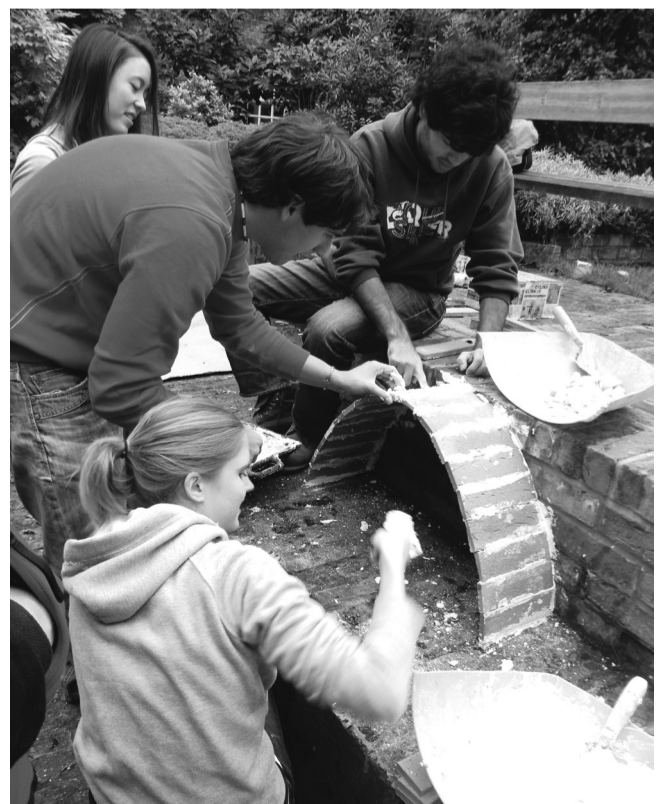
Modelos de superficies tabicadas de ladrillo en forma anticatenárica Fotografía: A. R. Ponce
