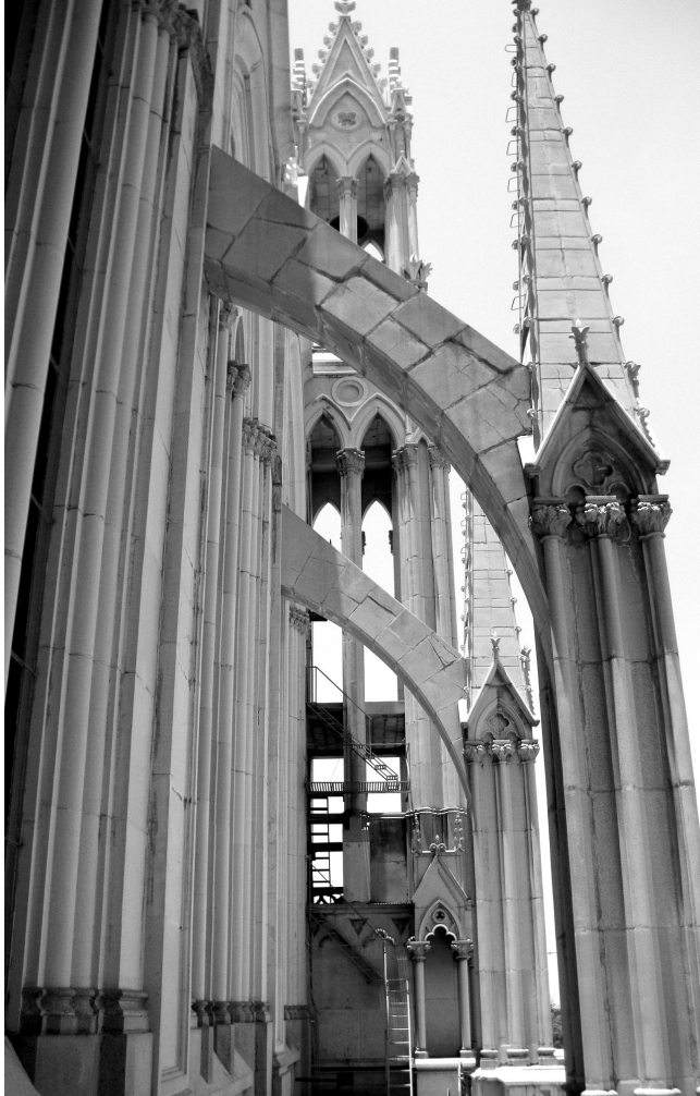
Uno de los tantos arbotantes que se encuentran en la parte superior del templo. Se trata de estructuras decorativas sin función estructural alguna.
