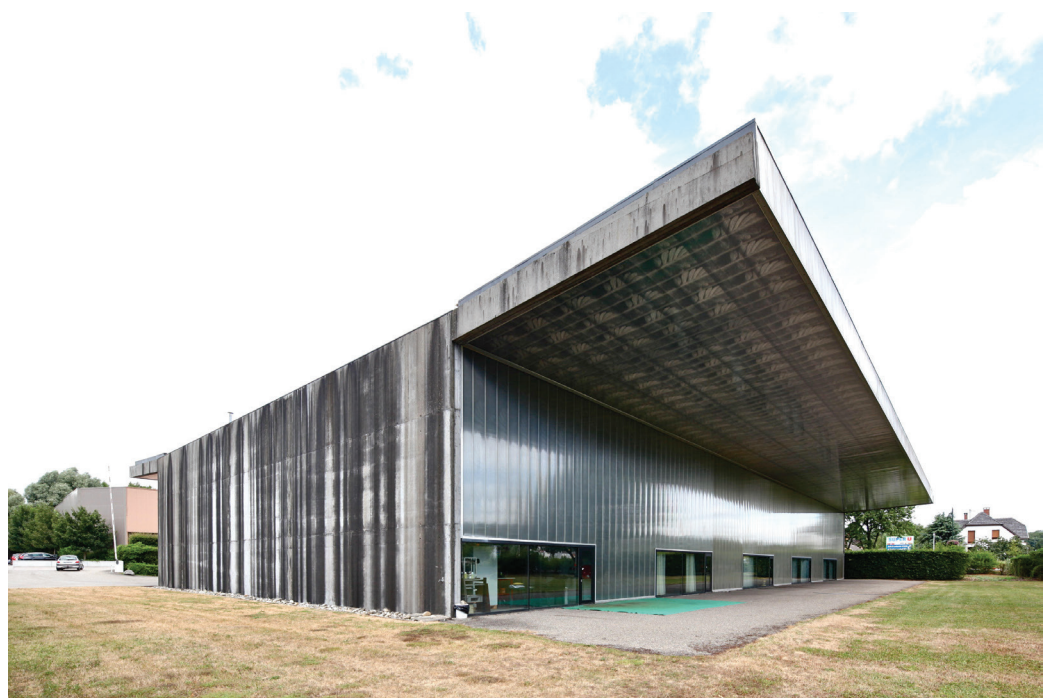
Edificio de producción y almacenaje de Ricola Europa, Mulhouse, Francia. Herzog & de Meuron, 1993 Fotografías: Eugeni Bach
