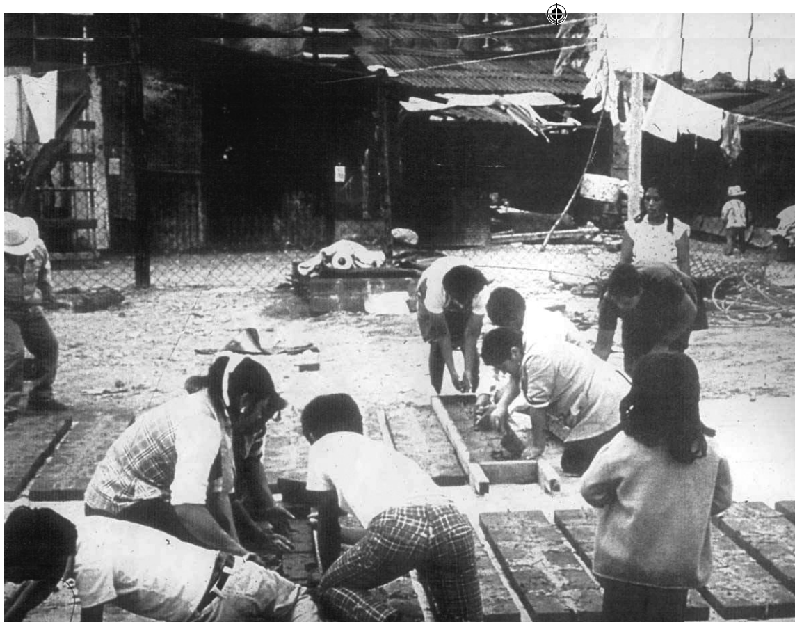
Producción de prefabricados en Palo Alto. Fotografía: Fabiola Cabrera
