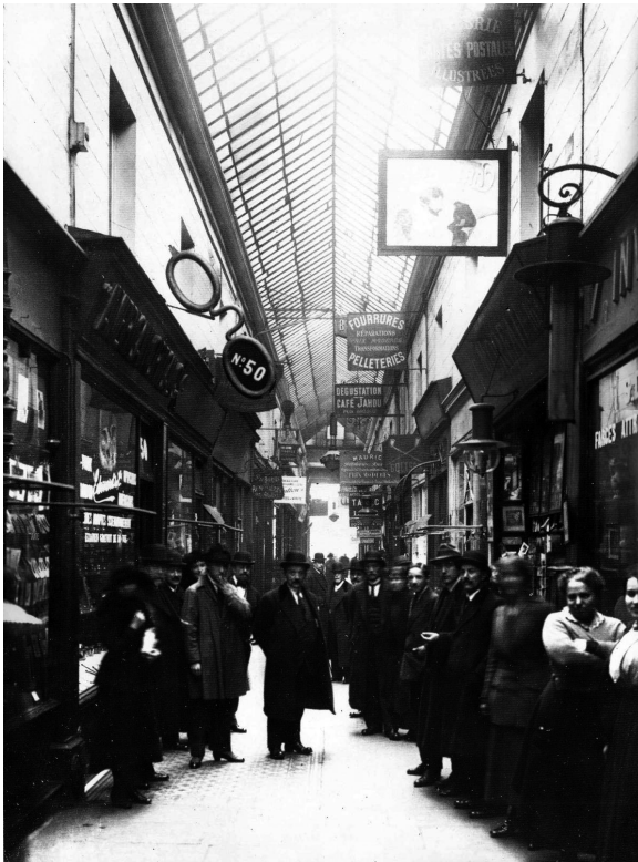
Passage des Panoramas. Fotografía: Moncan & Mahout. Ejemplo de como, techado con una estructura de madera o hierro y vidrio, se cerraba una calle angosta para permitir a ambos lados el establecimiento de comercios
