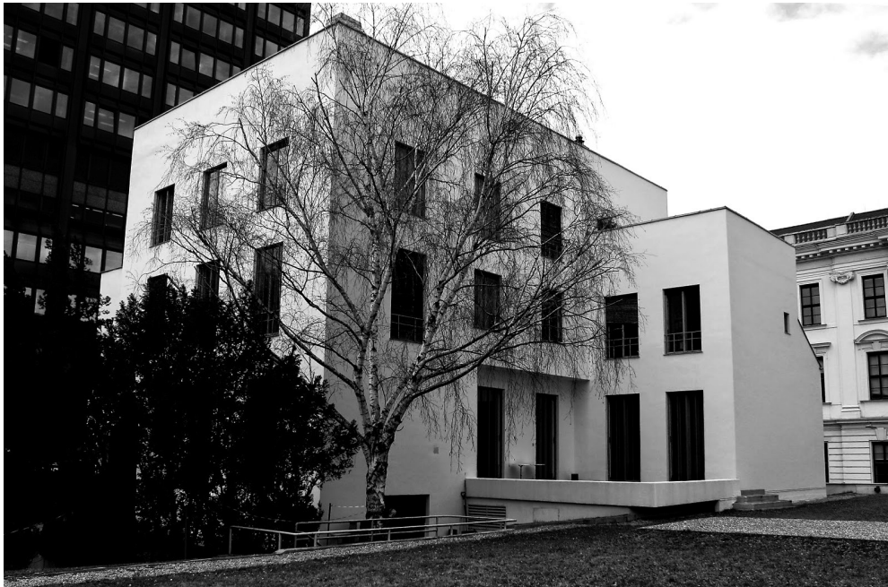
Casa Stonborough - Wittgenstein, vista desde el este. Situación actual
