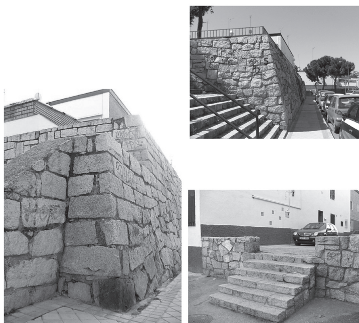
Muros de contención de mampostería. Fotografía: Federico Colella
