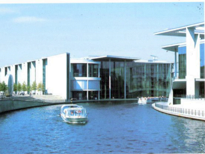
Stephan Braunfels, edificio de ME Lüders, sede de la biblioteca del parlamento Fotografía: GK
