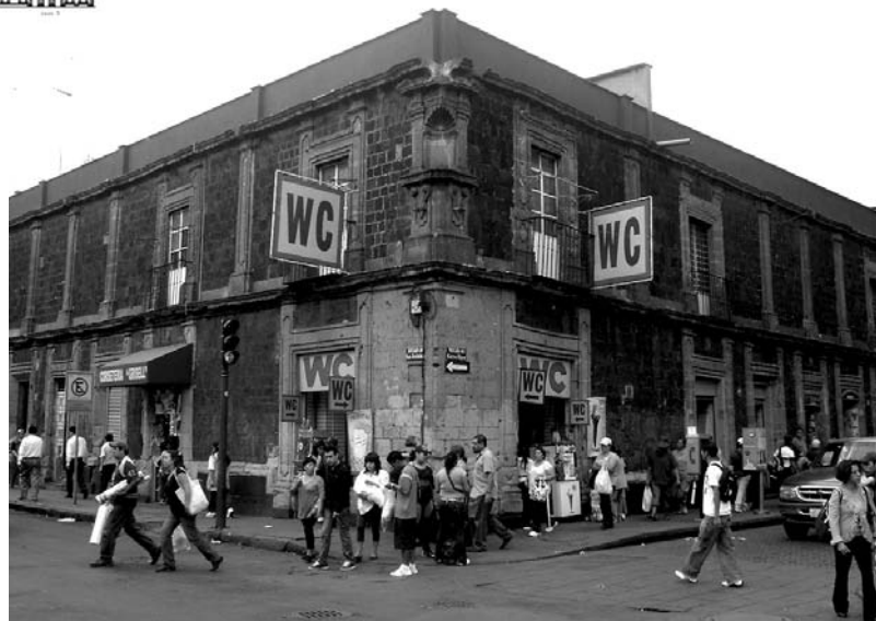
Estado actual del edificio que ocupó las Casas de la Buena Muerte Fotografía: Alfonso Zavala
