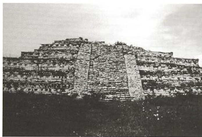
Vista frontal del Edificio 1 o Pirámide de los Nichos en Yohualichan, Puebla, desde la Plaza Principal.
