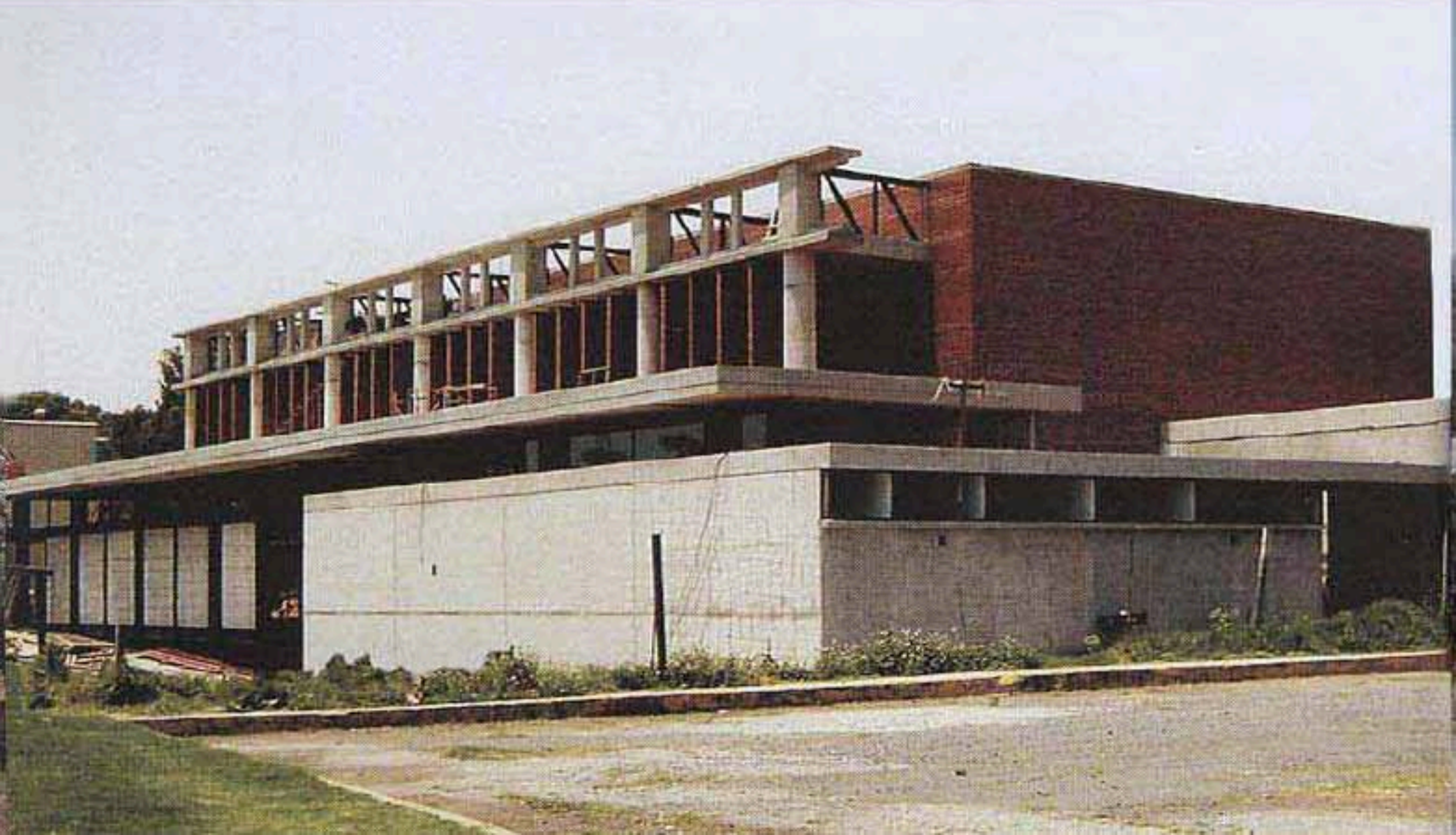
El edificio en construcción.
