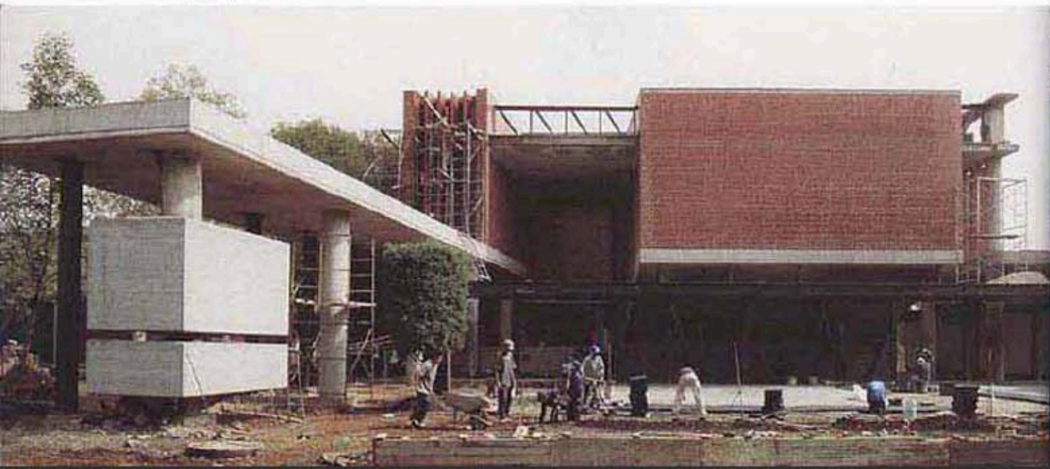
El Auditorio en construcción.
