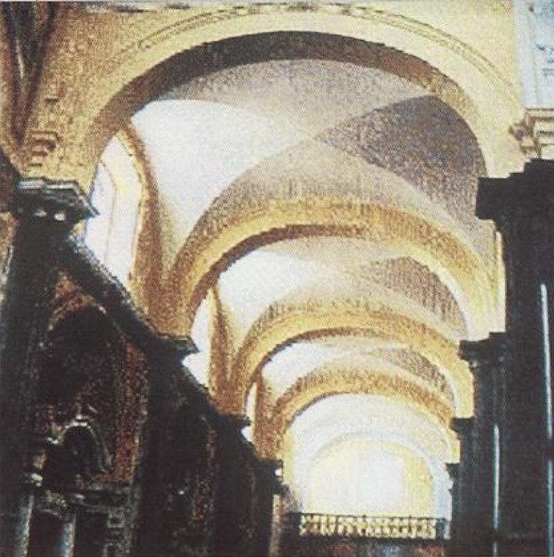
Templo de la Compañía de Jesús (rehabilitación estructural), Puebla, Armando Reyes.
