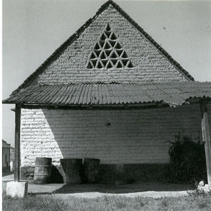
Casa de adobe con tapanco, con ventilación. Ayapango, Edo. de México.
