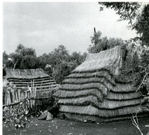
Vivienda de techo y muros de palma. El Mirador, Morelos.
