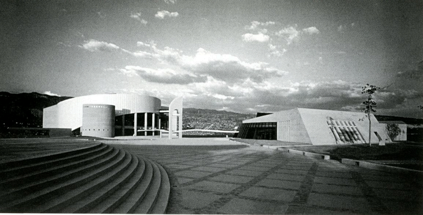
Sala de Usos Múltiples y Centro de Convenciones. Tuxtla Gutierrez, Chiapas. 1995. Foto: Timothy Hursley
