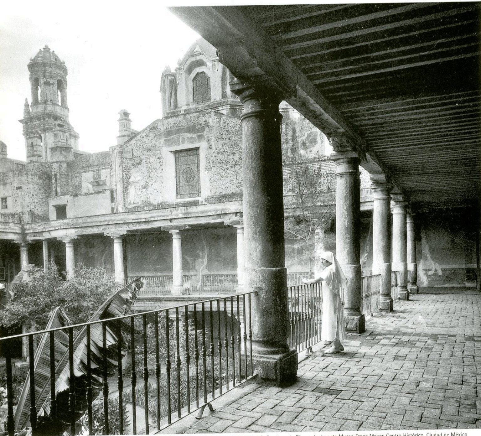
Corredor alto del Hospital Morelos. Antes Hospital de San Juan de Dios, actualmente Museo Franz Mayer, Centro Histórico, Ciudad de México 0015-30 CNMH Conaculta-INAH-MEX. Reproducción autorizada por el Instituto Nacional de Antropología e Historia
