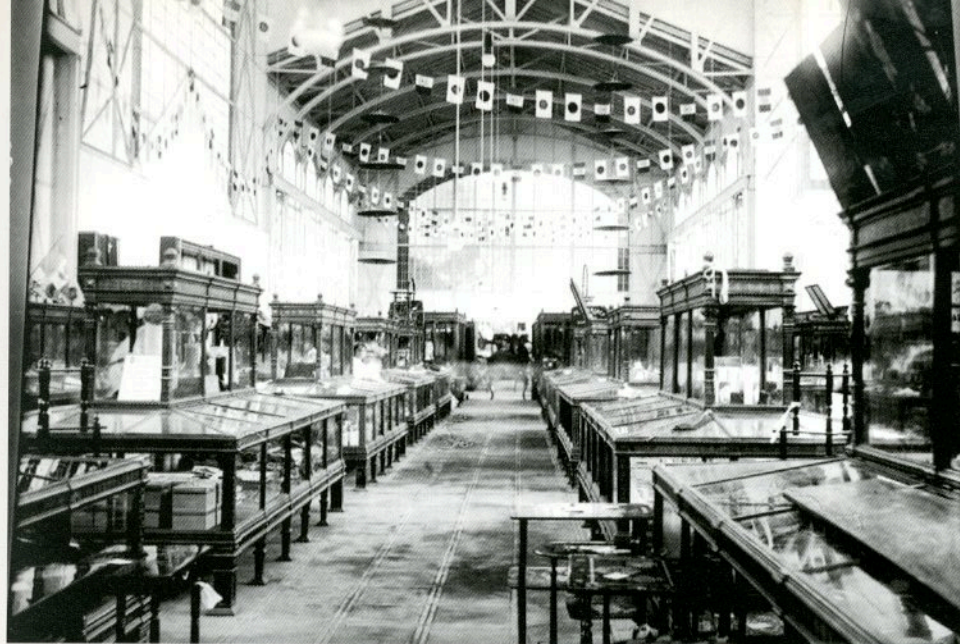
Vitrinas con artículos industriales japoneses en el Museo del Chopo, 1910. El edificio fue construido por la compañía alemana Gutehoffnungshütte para armar y montar en sitio. Actualmente se encuentra en proceso de renovación y ampliación Fuente: 84948 SINAFO-Fototeca Nacional. Reproducción autorizada por el Instituto Nacional de Antropología e Historia
