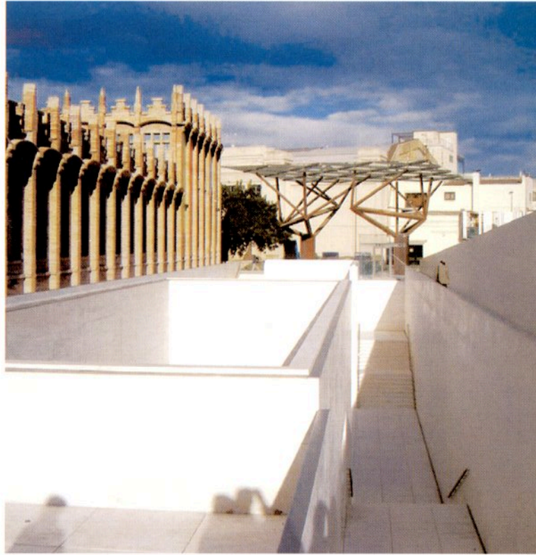
La Caixa Forum Barcelona instalada en la fábrica textil Casaramona, construida por Josep Puig i Cadafalch en 1910-1911; fue reciclada y ampliada por Roberto Luna, Javier Asarta y Arata Isozaki, 2003 Fotografía: Vanessa Loya
