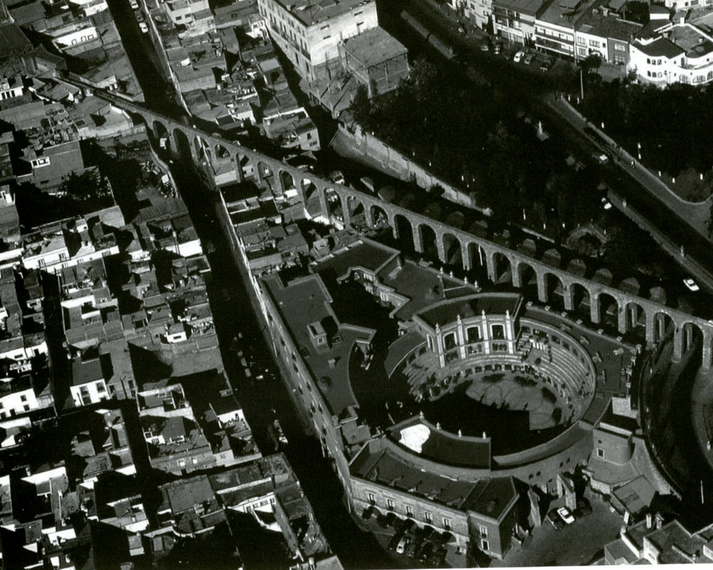
Antigua Plaza de Toros convertida en el hotel Quinta Real Zacatecas cuyo ruedo es el patio central Fotografía: Michael Calderwood
