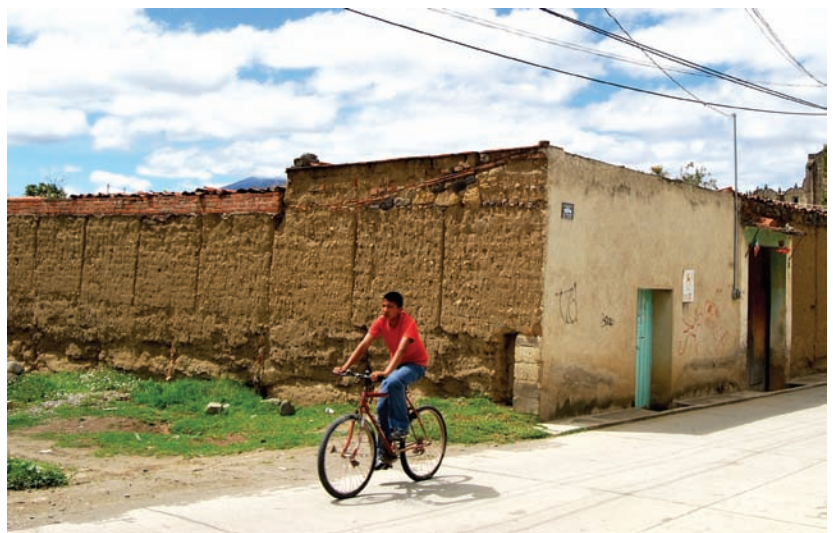
Vivienda con muros de tapia. Calpan, Puebla. Fotografía: Luis F. Guerrero
