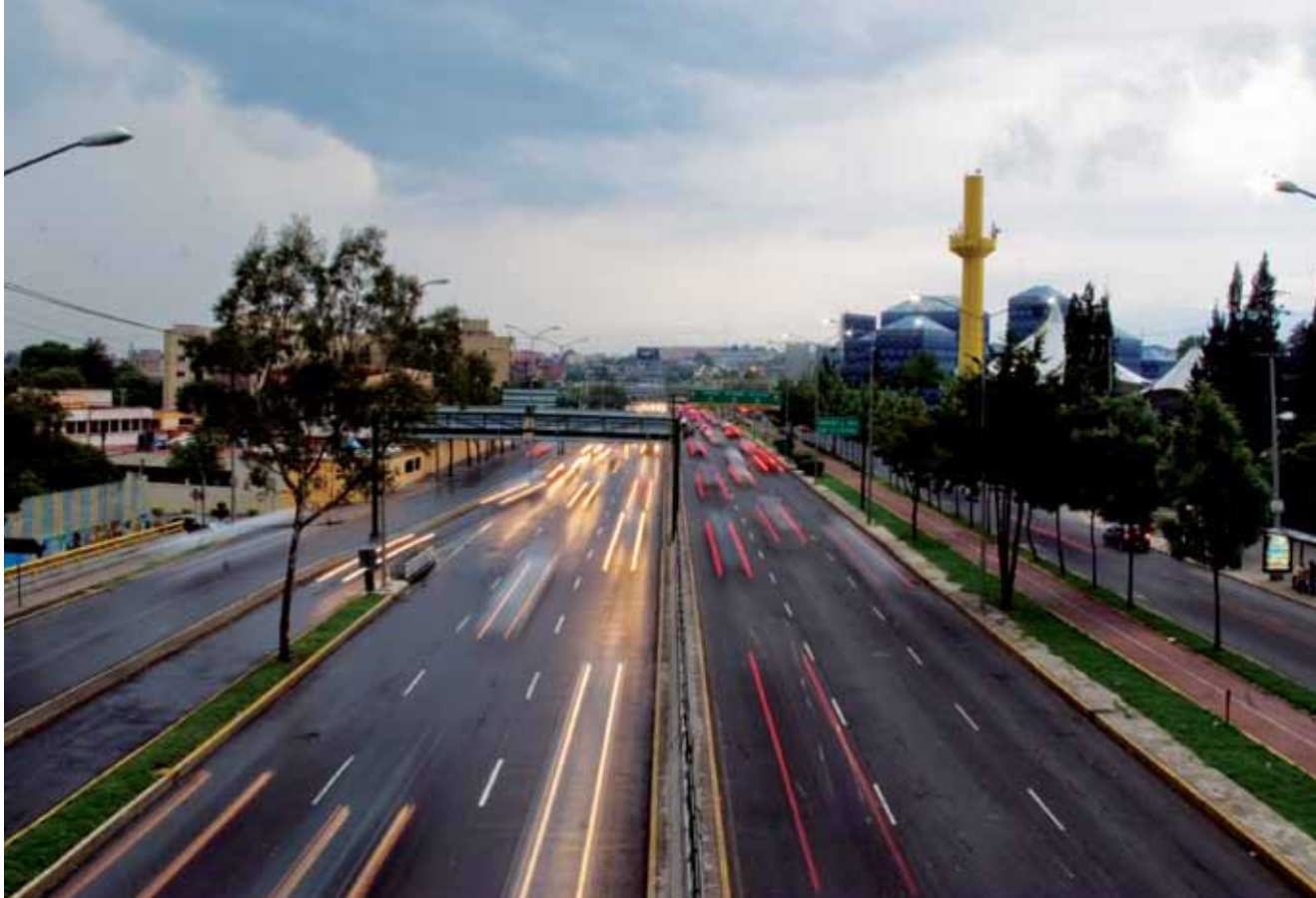
Vista del Anillo Periférico de norte a sur, a la derecha el Papalote Museo del Niño Fotografía: Onnis Luque
