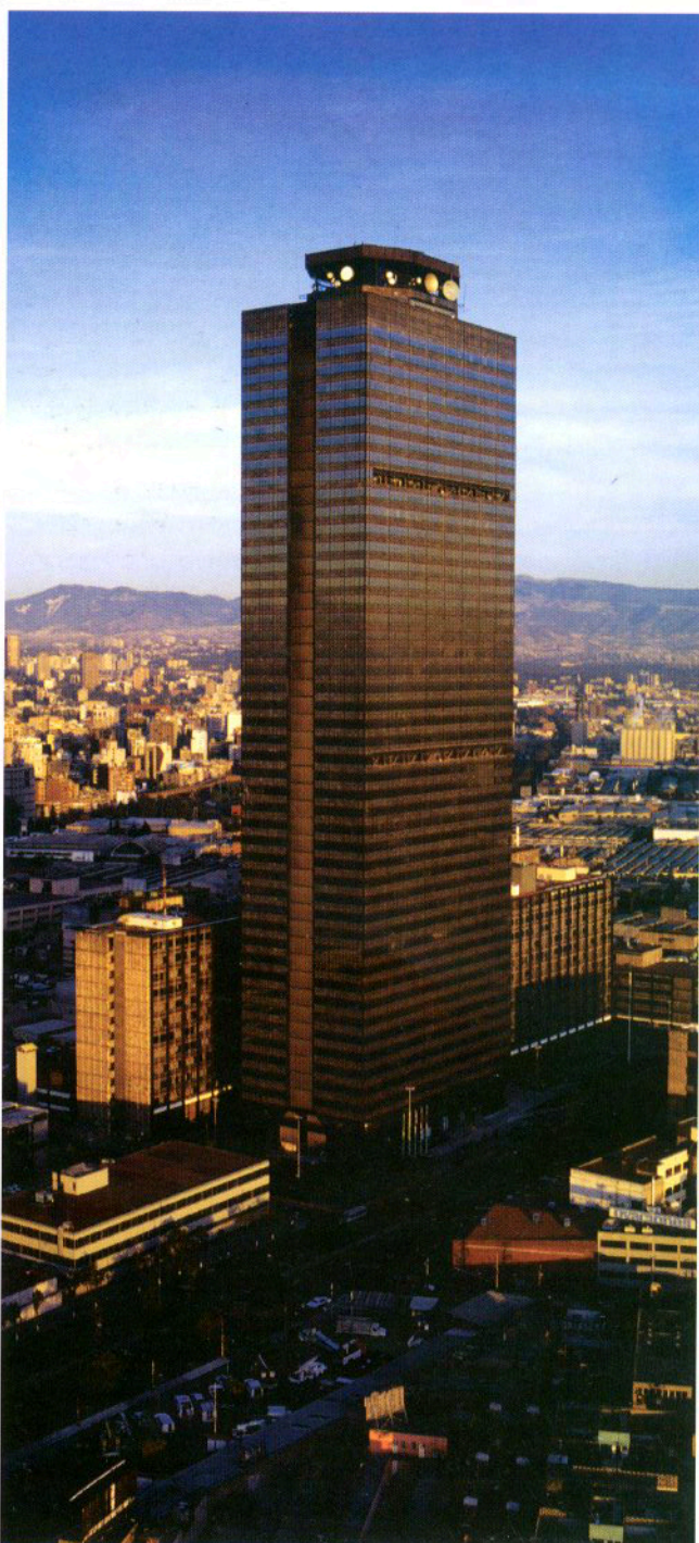
Pedro Moctezuma, Torre Ejecutiva Pemex, Avenida Marina Nacional 329 colonia Anáhuac, Ciudad de México, 1980-1982 Fotografía: Michael Calderwood
