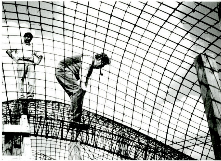
Carlos González Lobo revisa el armado de bóvedas en la iglesia de San Felipe de Jesús, El Mirasol, Estado de México, 1994 Imágenes del archivo: Carlos González Lobo, fotografía: María Eugenia Hurtado
