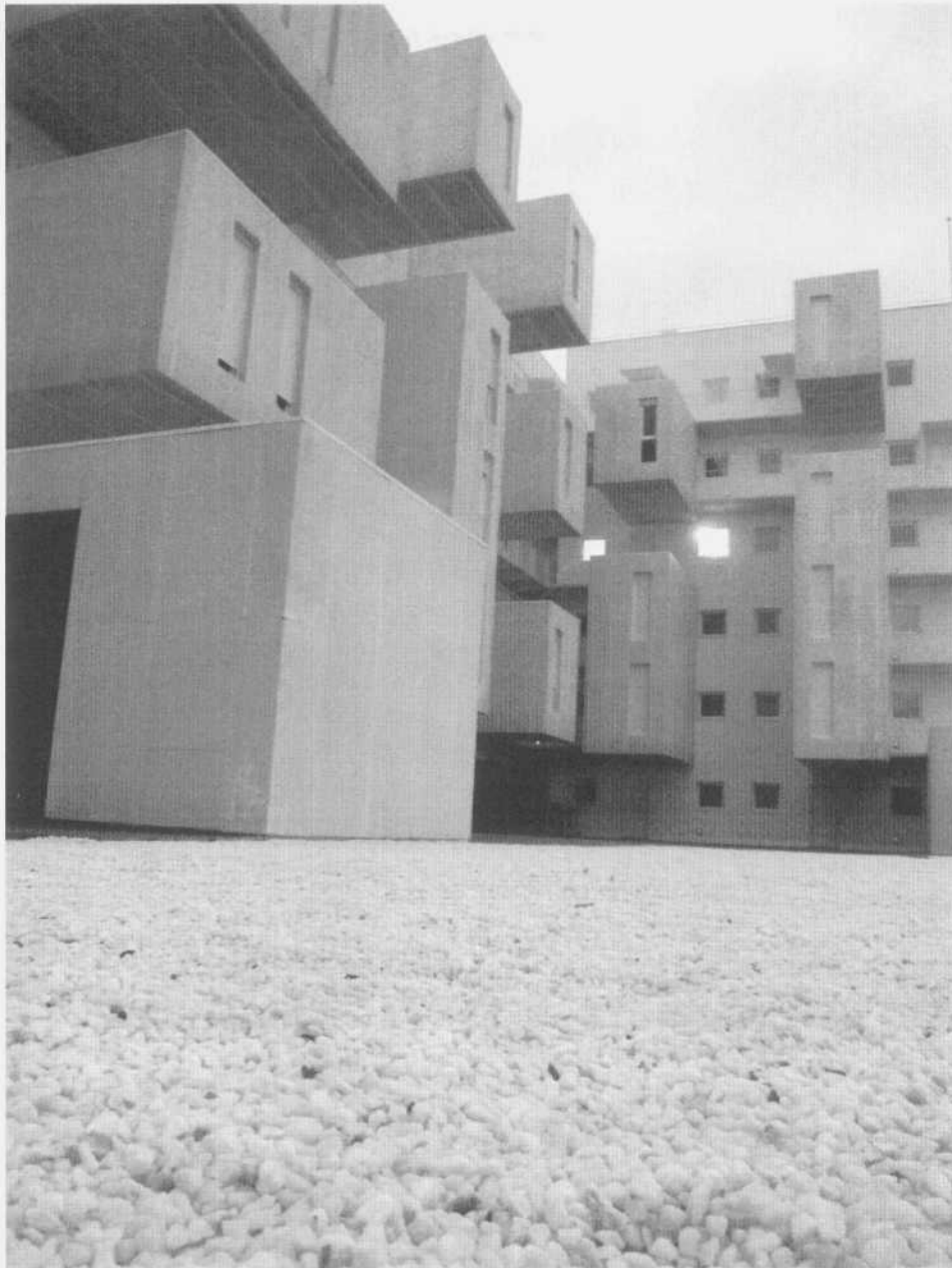
"Conjunto de vivienda de Dos más Uno." Arquitectos Ignacio Borrego, Néstor Montenegro y Lina Toro Fotografía: José Grinberg (México).
