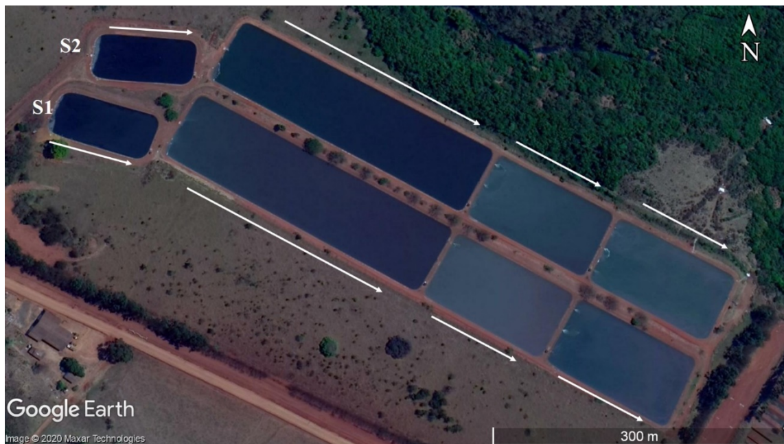
Figura 1. Sistemas de lagoas de estabilização da ETE Sapo.
