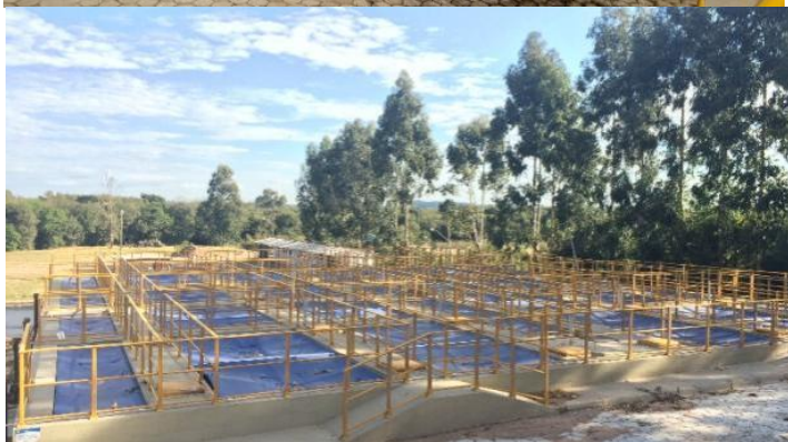
Figura 2. Tampas das canaletas de decantação e na câmara de gás dos dois reatores
