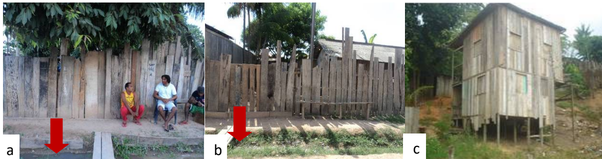
Figura 6. a) e b) Lançamento de esgoto a céu aberto. c) Banheiro no “quintal” dos domicílios.
