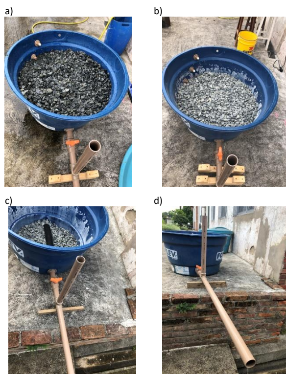
Figura 3. Módulo experimental: a) com camada granular e água; b) com camada granular e sem água; c) visualização do tubo de drenagem envolto por manta geotêxtil; d) detalhe do ponto de descarga livre.
