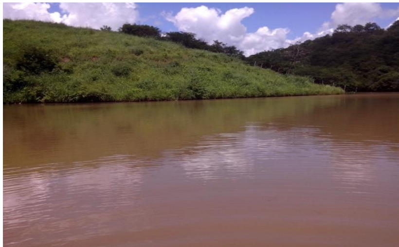
Figura 4. Pequeno açude no sítio Inxu em Crato (CE). Fuente: autoria dos autores.
