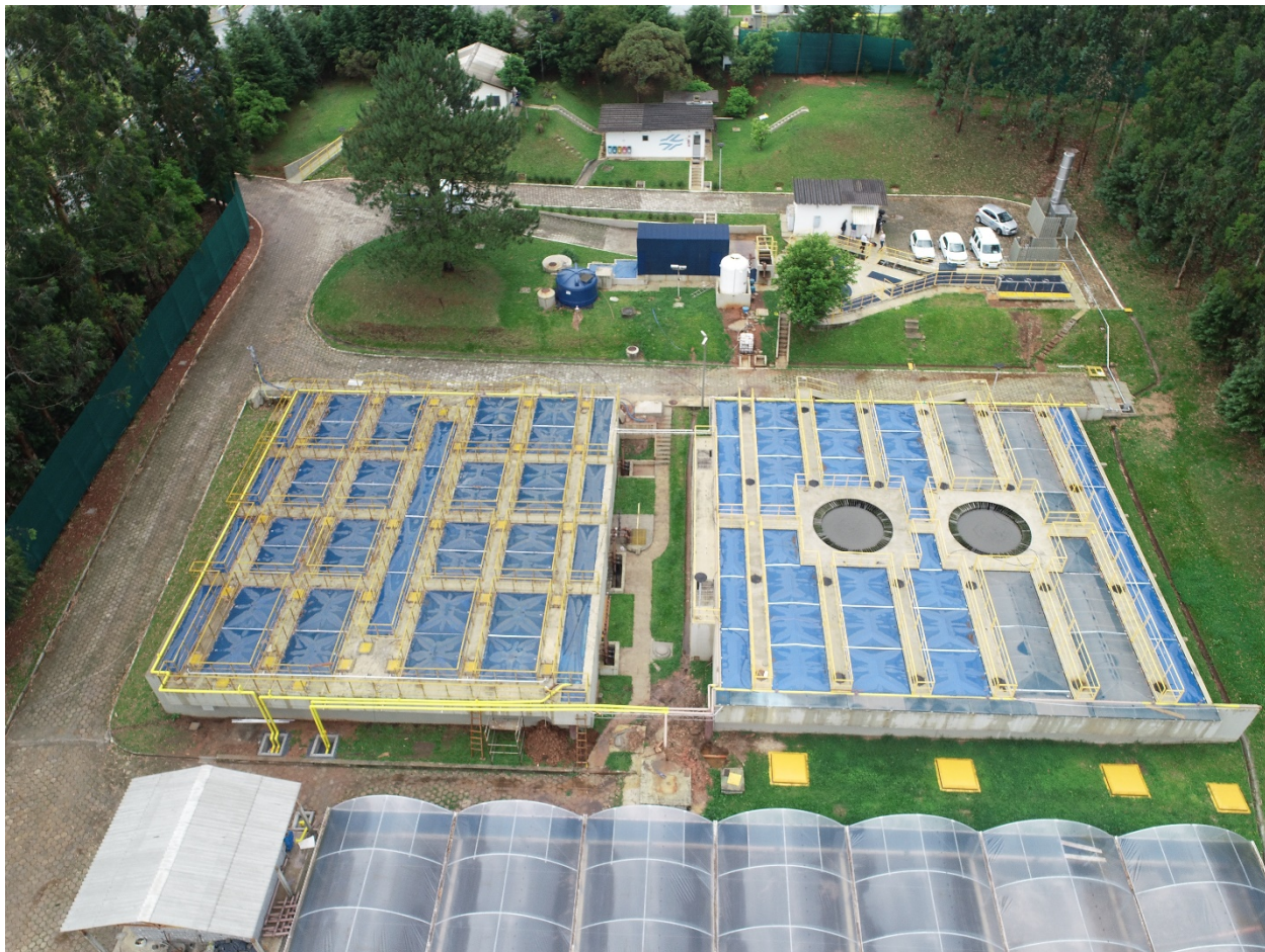
Figura 1. Foto aérea da Estação de Tratamento de Esgotos em Araucária. Fonte: própria.
