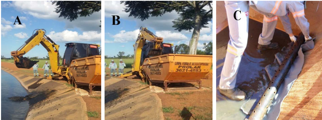
Figura 2. Coleta de lodo em lagoa anaeróbia (2A) e sua disposição (2B) em caçamba metálica (2C) para remoção do excesso de umidade.
