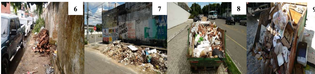
Figuras 6 e 7: Pontos de disposição irregular de RCD e de resíduos orgânicos e de podaço em caçambas destinadas exclusivamente a RCD. Fonte: Lima, T. B. R., 2017.
