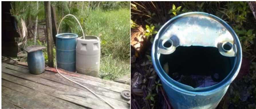
Figura 2. Reservatórios com água suscetível a contaminação.
